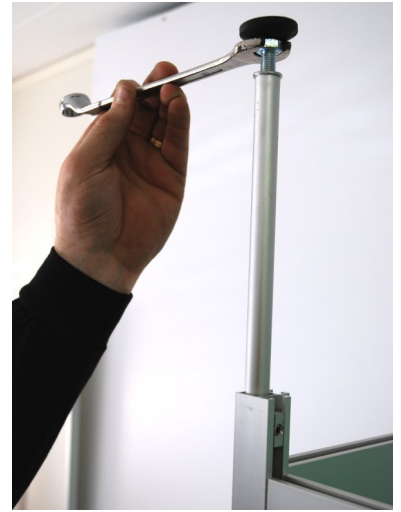
Ställskruv för slutlig låsning
