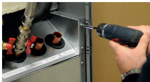
3. Avlägsna kylmodulens fästskruvar.
