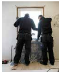
Nya fönstret sätt på plats.
