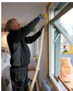
Ny isolering mellan karm och vägg.
