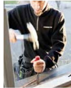
Lossa gammalt foder på utsidan.
