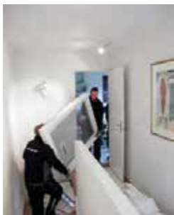
Dags att hämta det nya fönstret.
