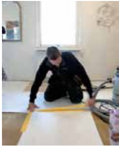
Förbered noga med skyddspapp.
