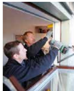
Förmonterad karmskruv följer karmen.
