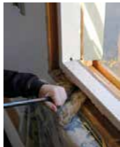
Gammal drevning petas fram och slängs.
