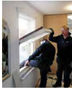
Ta bort den gamla fönsterbågen.
